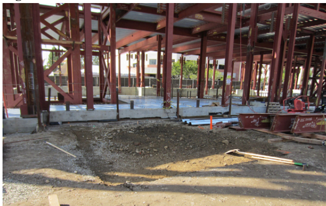
Figura 32: Estrutura do Edifício.
