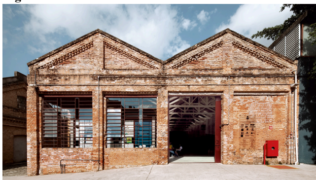
Figura 36: Fachada do Instituto.
