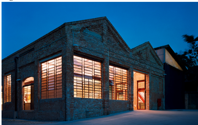
Figura 37: Vista do Edifício.
