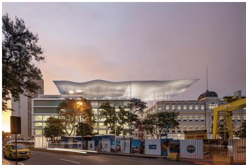
Figura 15: Fachada do Museu de Arte do Rio (MAR).
