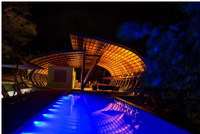
Figura 12 – Estrutura Mirante do Gavião | Amazon Lodge
