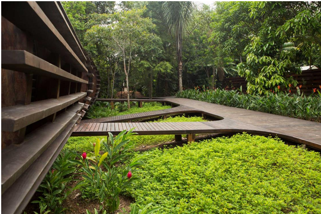
Figura 13 – Implantação de edificação elevada
