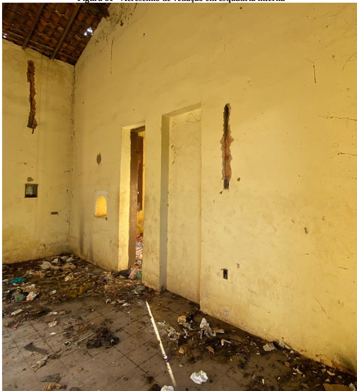
Figura 81 - Acréscimo de vedação em esquadria interna
