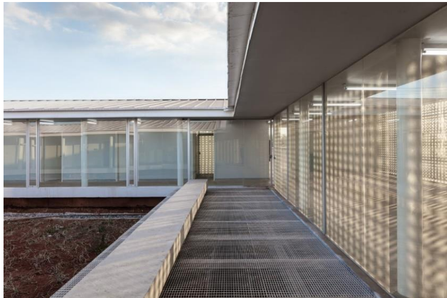
Figura 15: Obra em finalização
