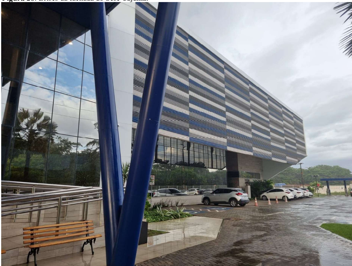
Figura 28: Brises da fachada do Sesc Cajuína.
