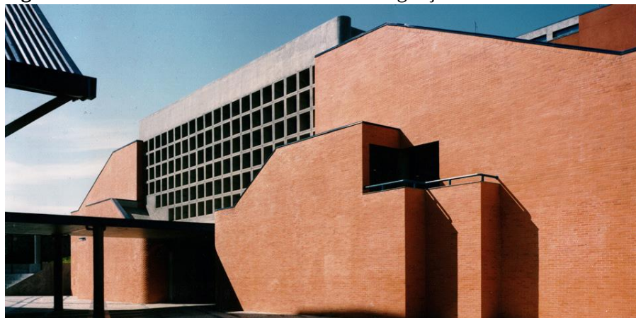
Figura 25 - Fachada do teatro do SESC Nova Iguaçu.
