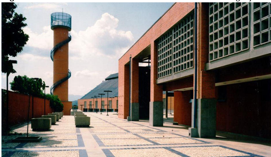
Figura 28 - Vista lateral do Edifício administrativo do SESC Nova Iguaçu.
