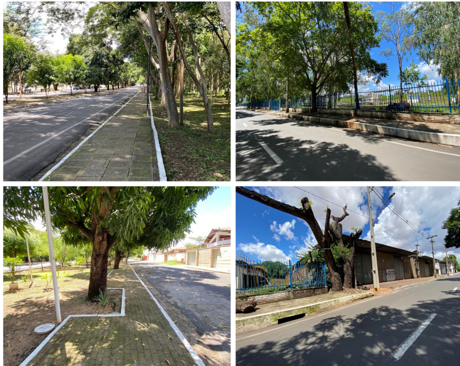
Figura 35: Escassez de acessos e rampas adequadas.
