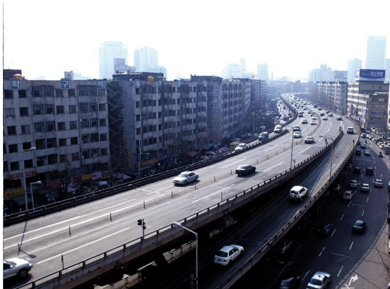
Figura 9: Viaduto sobre o córrego Cheonggyecheon.
